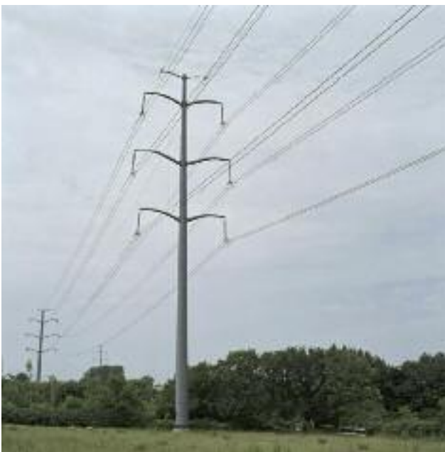
Fig. 147 : Exemples de supports dits architecturés : pylônes type « Muguet » et « Roseau » sur ligne 400 000 V.
