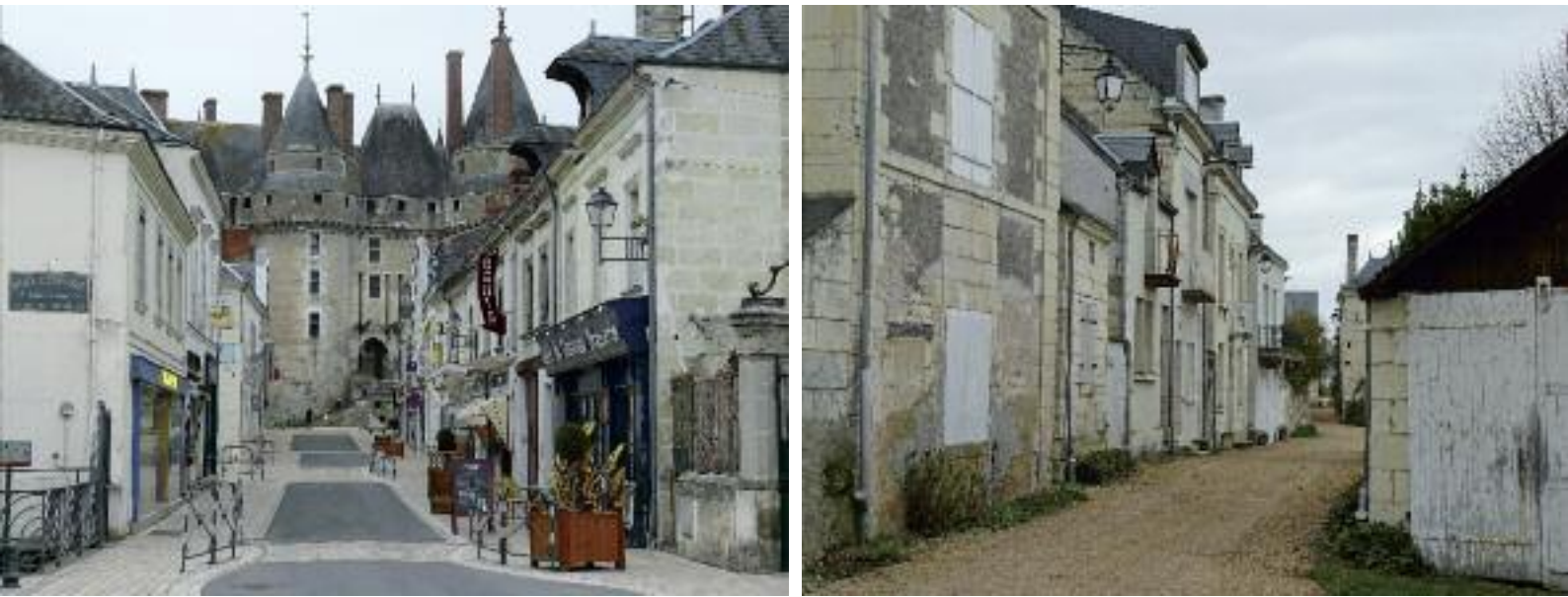
Fig. 148 : Enfouissement des lignes aériennes de distribution au cœur de la ville : une redécouverte du patrimoine architectural, une valorisation des perspectives.
